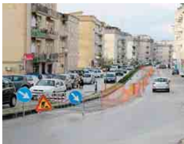
PROBLEMI AL MANTO STRADALE DI UN LUNGO TRATTO DI VIA PALADINI
